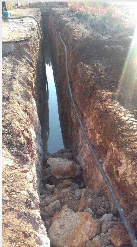
Εκσκαφή χερσαίου τμήματος υποθαλάσσιου αγωγού
