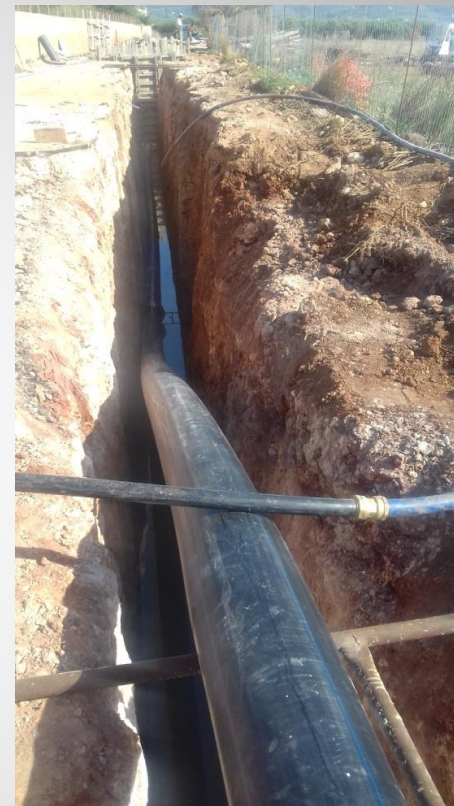
Τοποθέτηση χερσαίου τμήματος υποθαλάσσιου αγωγού
