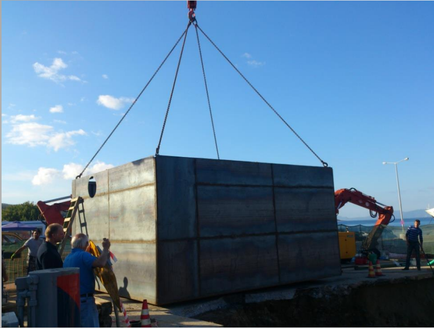
Μεταφορά και τοποθέτηση μεταλλότυπου για την σκυροδέτηση των τοιχίων του Κεντρικού Αντλιοστασίου.
