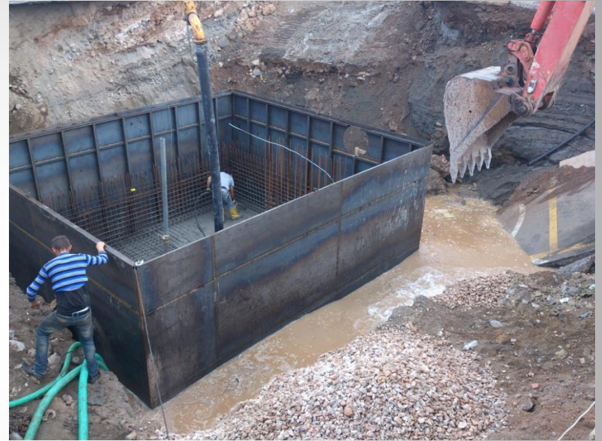
Μεταφορά και τοποθέτηση μεταλλότυπου για την σκυροδέτηση των τοιχίων του Κεντρικού Αντλιοστασίου.
